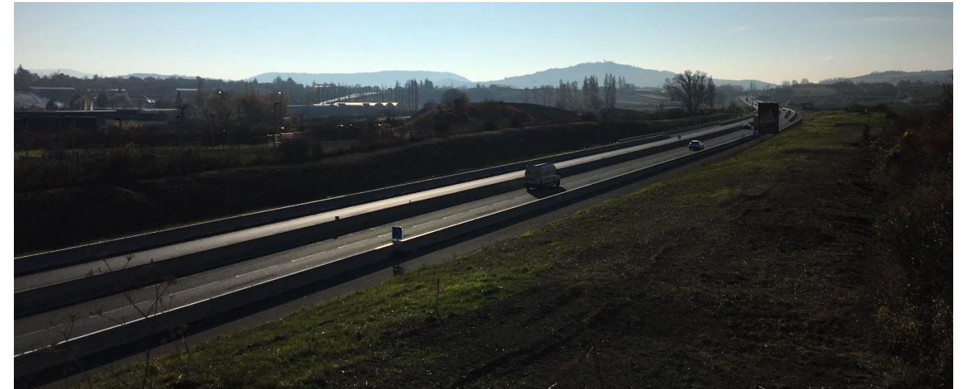
Figure 71 : L'A75 depuis le pont autoroutier de la RD 756 (source : Ingerop, novembre 2018)
