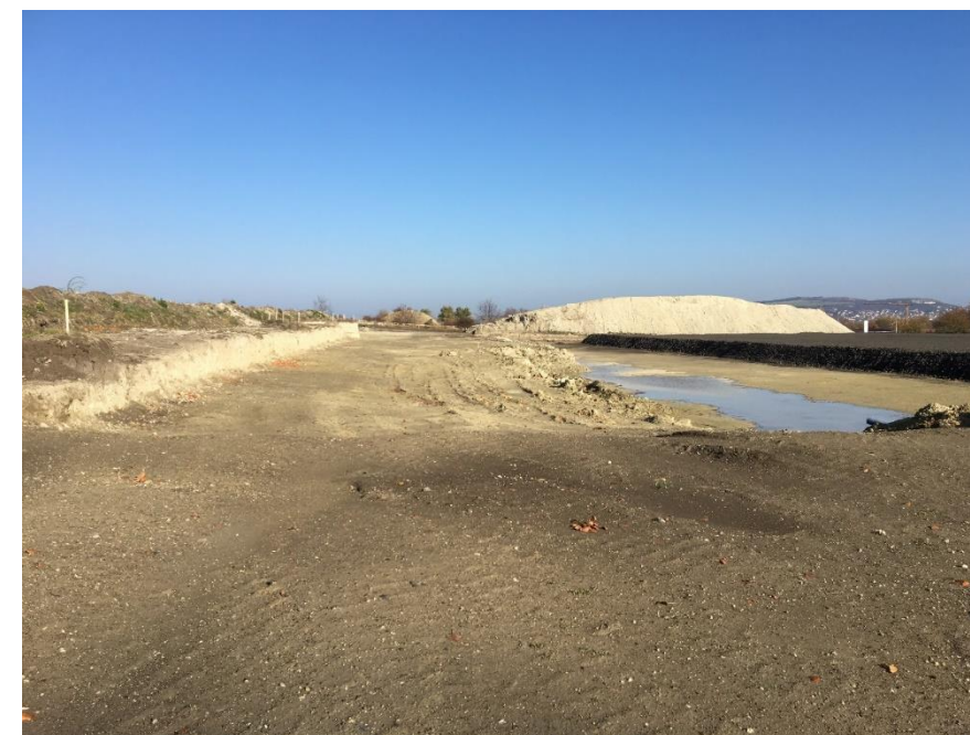
Figure 68 : Photographie du site au sud après démolition du bâtiment agricole (source : Ingerop novembre 2018)
