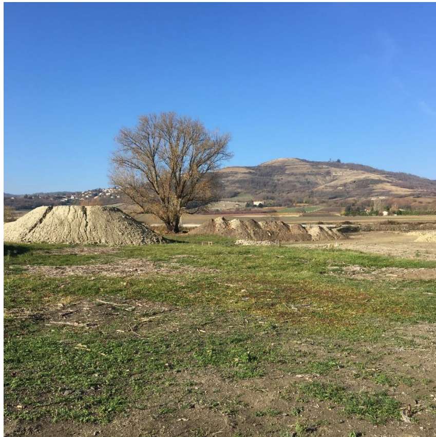
Figure 70 : Photographie du secteur d'aménagement sud après démolition du bâtiment agricole et habitation (source : Ingerop, novembre 2018)
