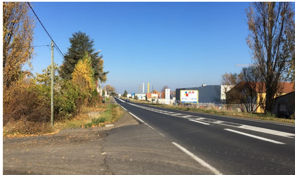
Figure 73 : Photographie de la RD 978 au droit de l'aire d'étude (source : Ingerop, novembre 2018)
