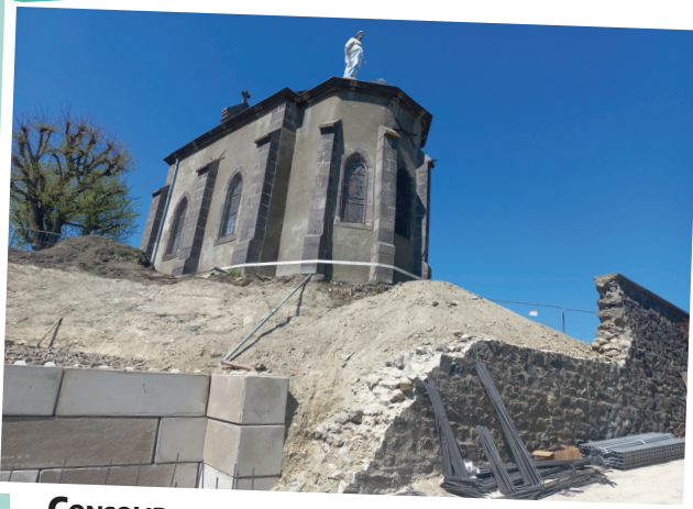
CONSOLIDATION MUR DE LA CHAPELLE
