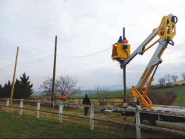
Suite au remplacement des poteaux en contre-bas du terrain, dont un poteau abîmé par la foudre, les employés ont également nettoyé la zone et installé à l'aide d'une nacelle le nouveau filet pare-balloons.
